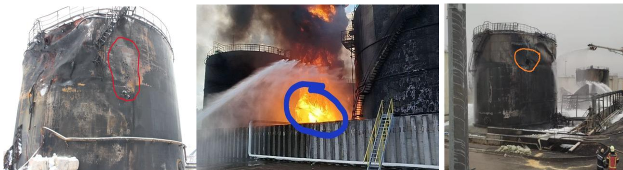
Рисунок 11 – Примеры поражений РВС военными средствами поражения
