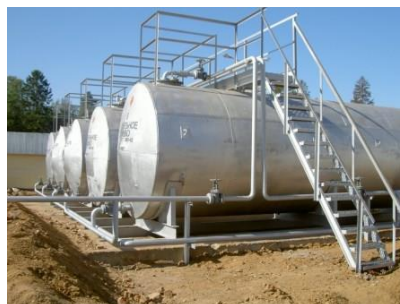
Рисунок 3 – Примеры установки резервуаров в парках
