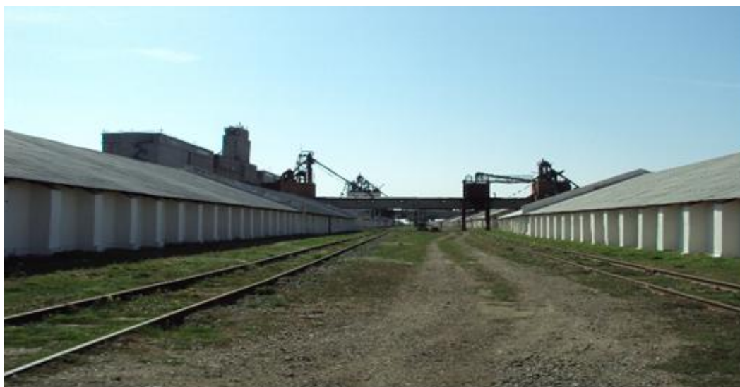
Рисунок 5 - ОАО «Шильдинский элеватор» (вид со стороны железной дороги)
