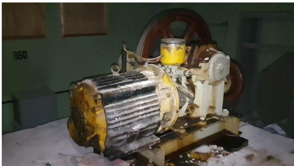
Рисунок 8 – Электродвигатель лифтовой с приводом АС-72
