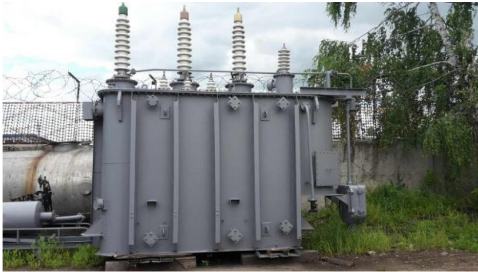
Рисунок 4 – Трансформатор ТМН-6300/110
