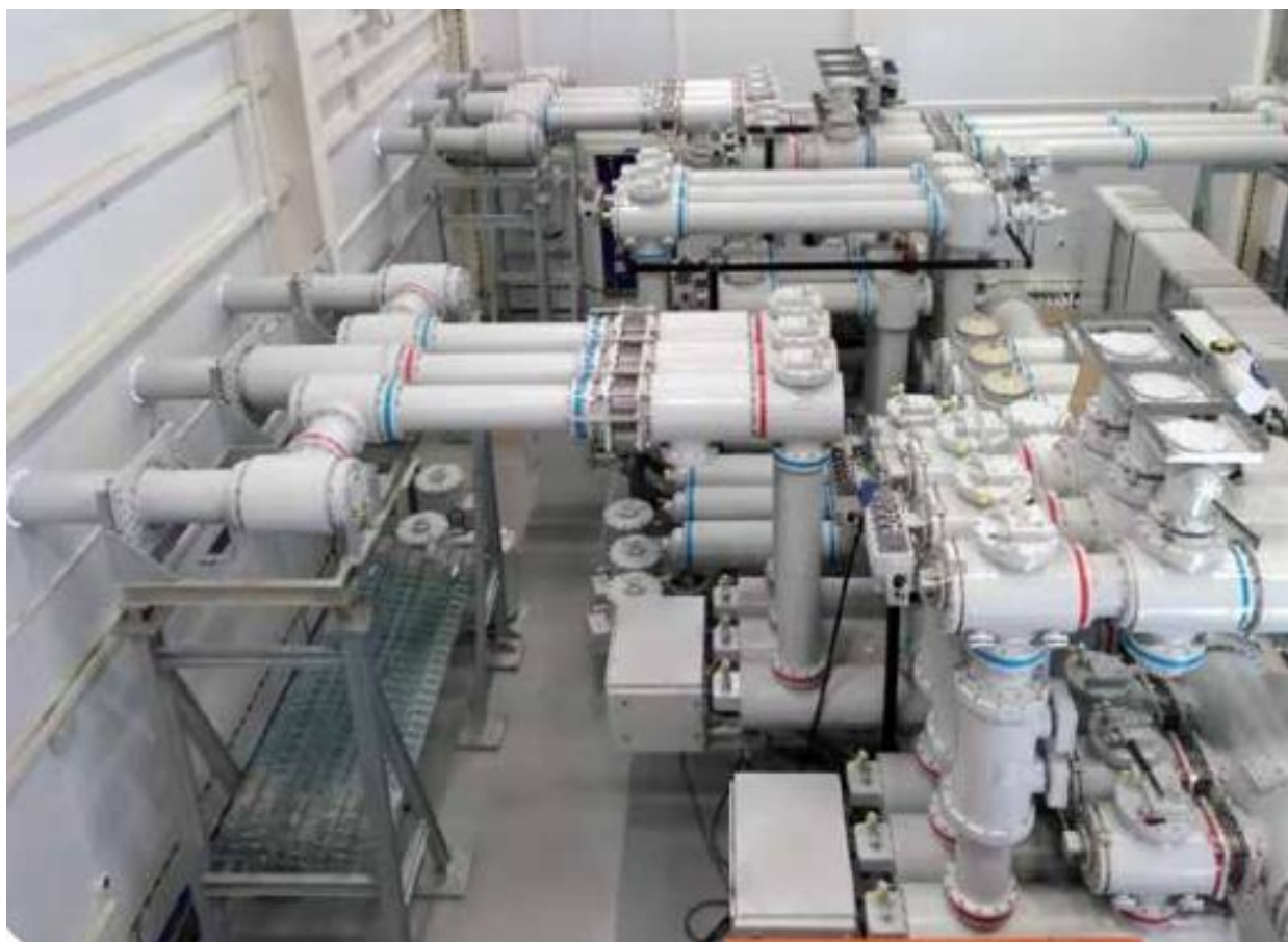
Рисунок 9 – КРУЭ серии ЯГТ-110 АО ВО «ЭЛЕКТРОАППАРАТ»
