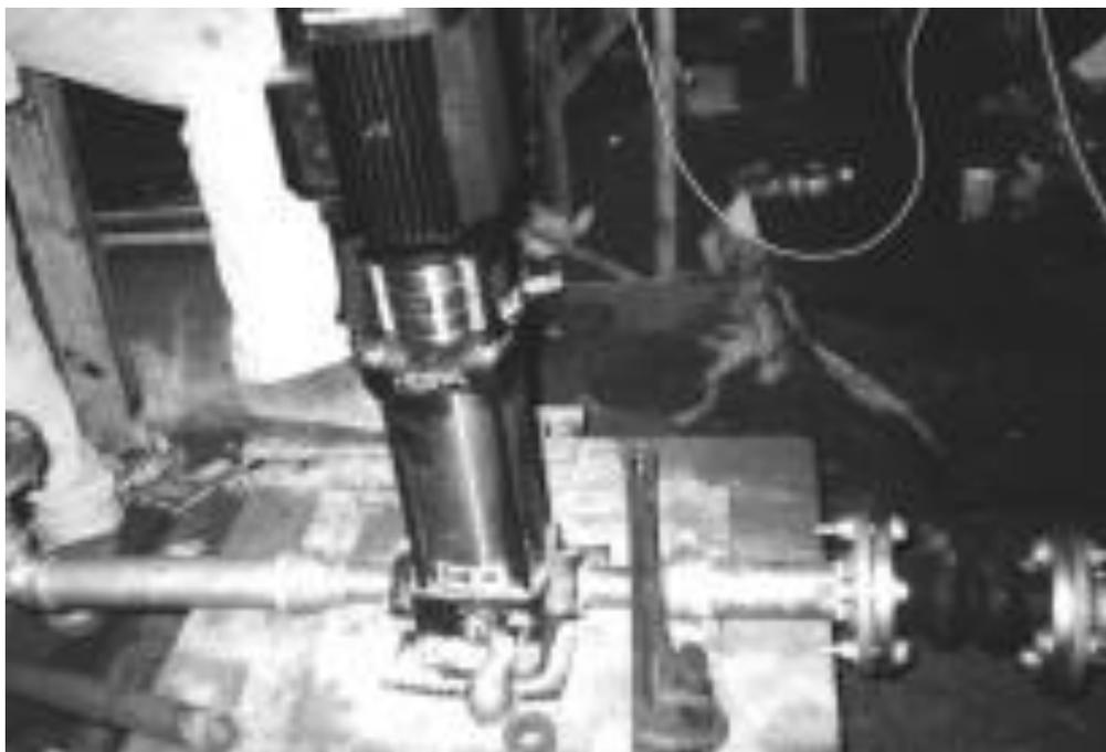
Рисунок 14 – Инерционный блок, пружина, изолирующая прокладка и гибкий соединитель
