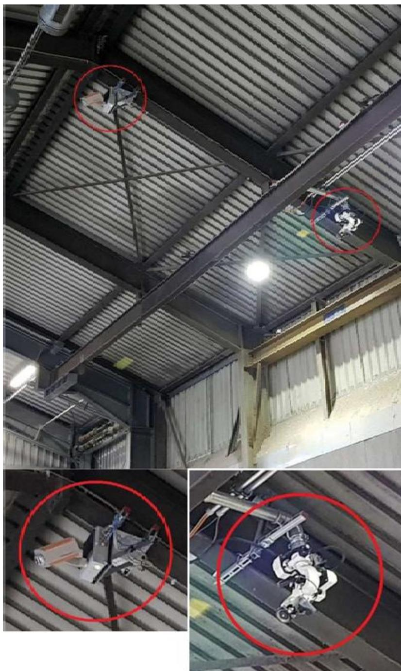
Рисунок 3 – Система обнаружения тепла PYROsmart и монитор с дистанционным управлением в производственном здании
