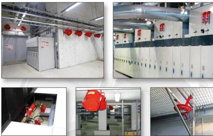
Рисунок 6 – Различные места установки систем пожаротушения Salgromatic
