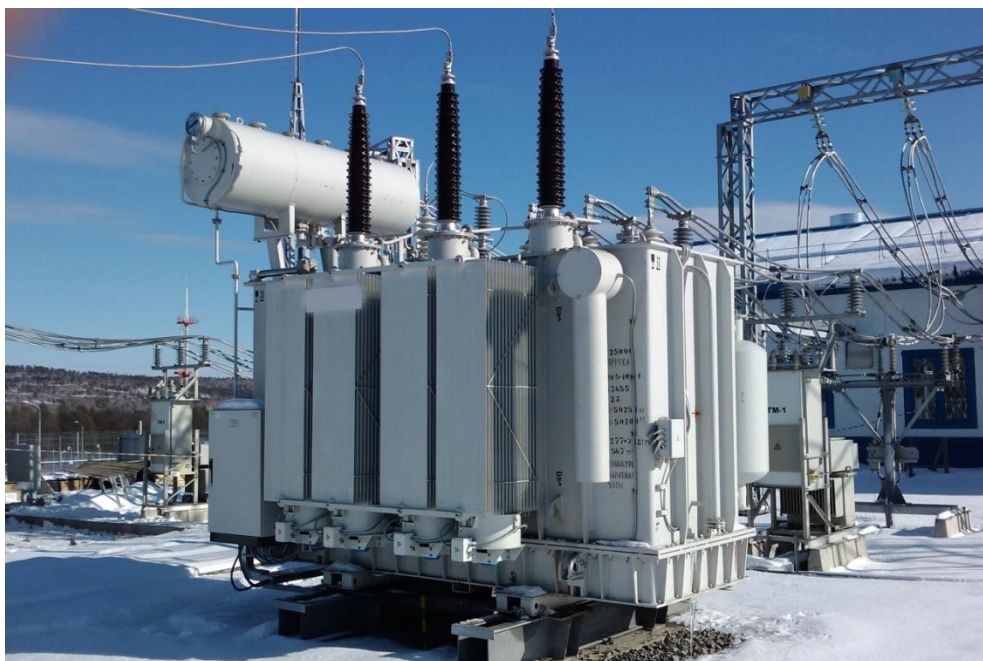
Рисунок 1 – Трансформатор ТДН-25000/110
