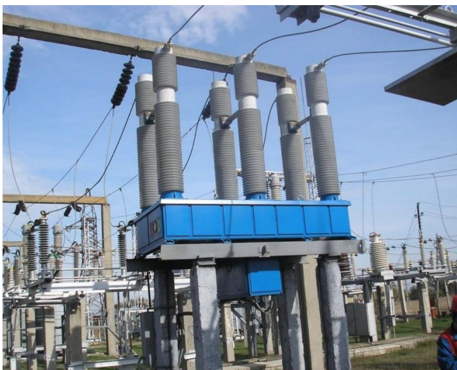
Рисунок 3 – Выключатель 110 кВ
