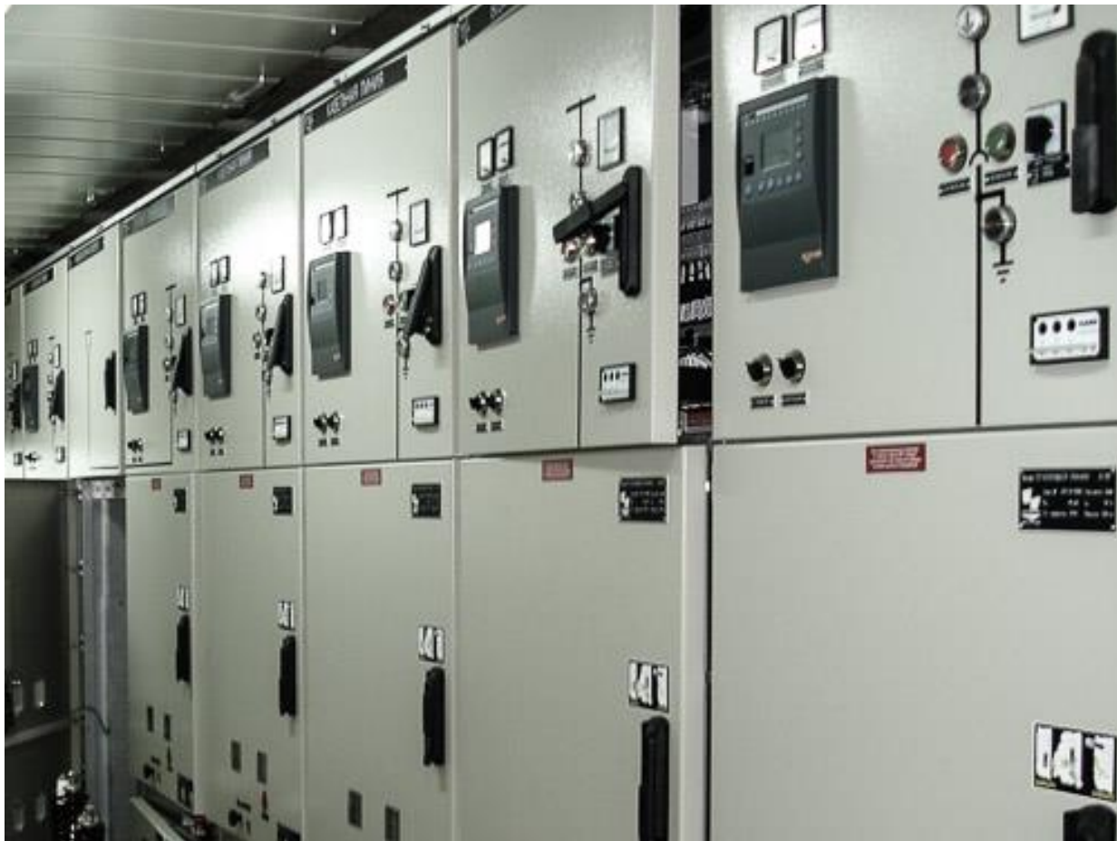
Рисунок 5 – Конструкция и размещения ячеек КРУ 6 (10) кВ «Классика»
