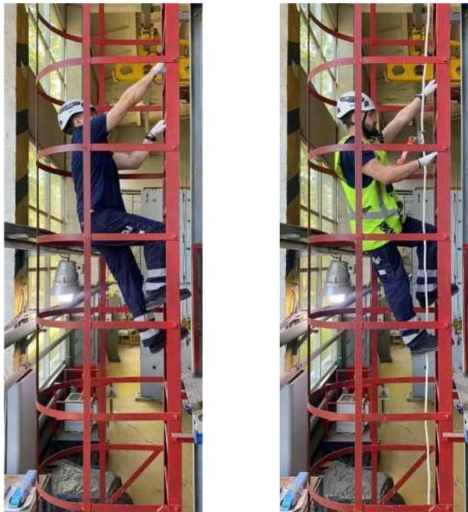
а) Позиционирование без использования системы безопасности б) Позиционирование с использованием системы безопасности
