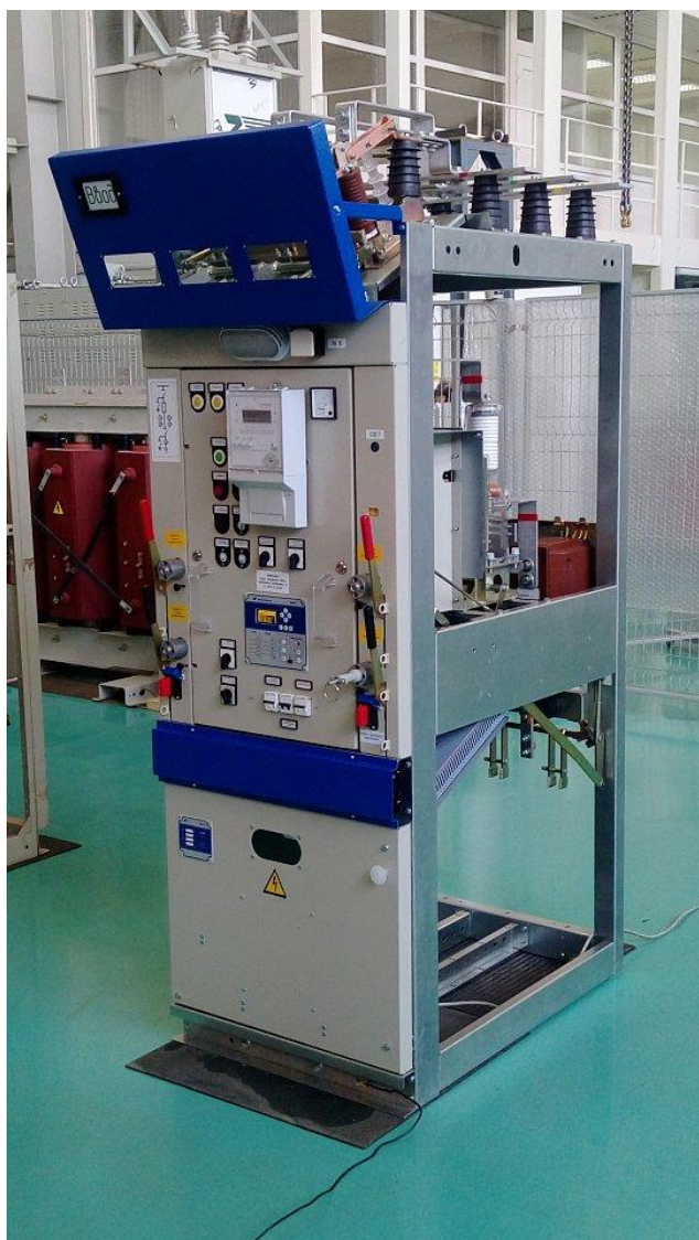
Рисунок 4 – Камера типа КСО-298М-1000
