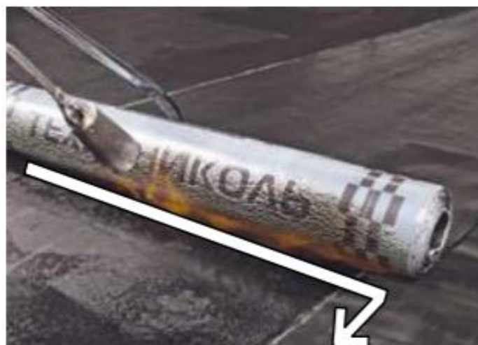
Рисунок 12 – Движение горелки при наплавлении смежных рулонов
