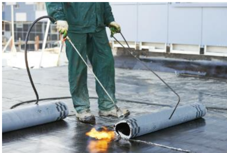
Рисунок 11 – Разогрев рулона
