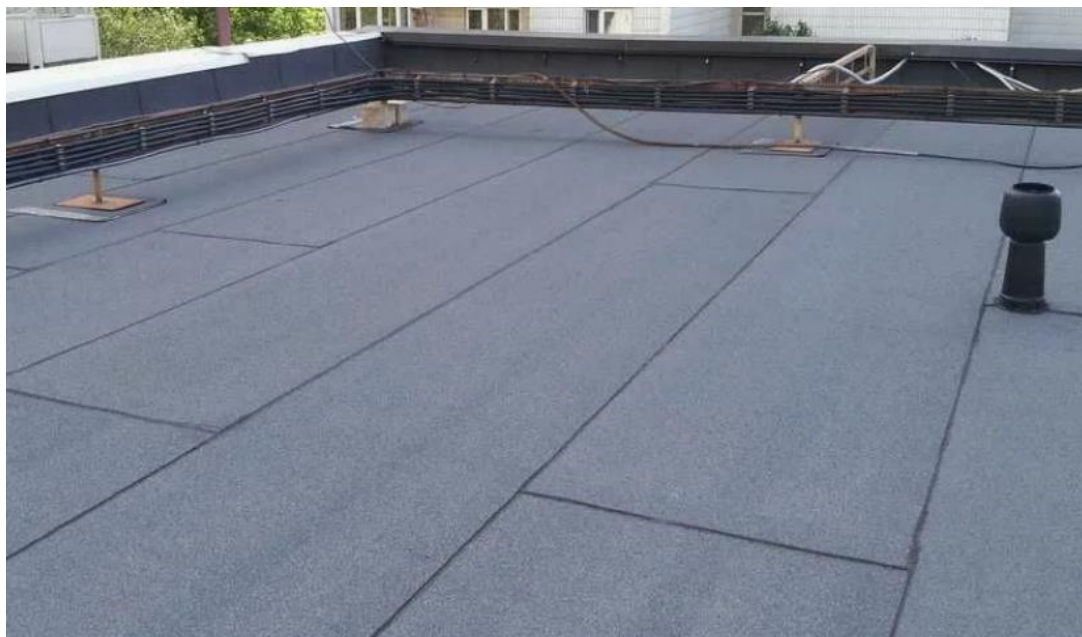
Рисунок 13 – Общий вид кровли после наплавления
