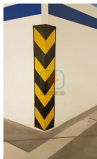
Рисунок 7 - Угловой демпфер на колонну
