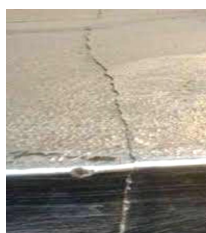
Рисунок 20 – Трещина напряжения
