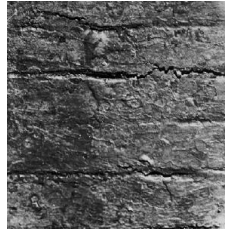
Рисунок 7 – Поперечные трещины
