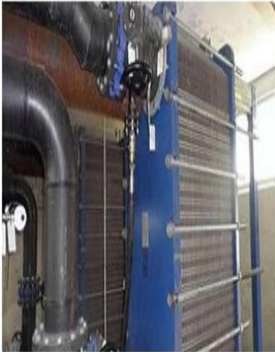
Рисунок 1 - Пластинчатый теплообменник в Asnaesvaerket
