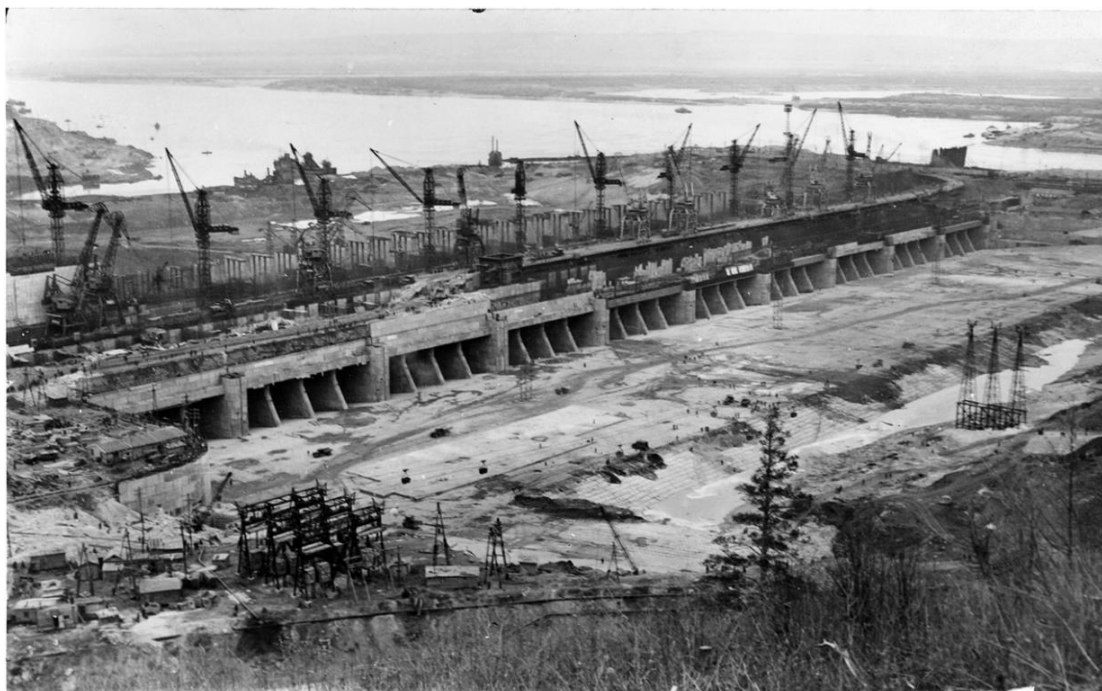
Рисунок 3 – Строительство Жигулевской ГЭС г. Тольятти
