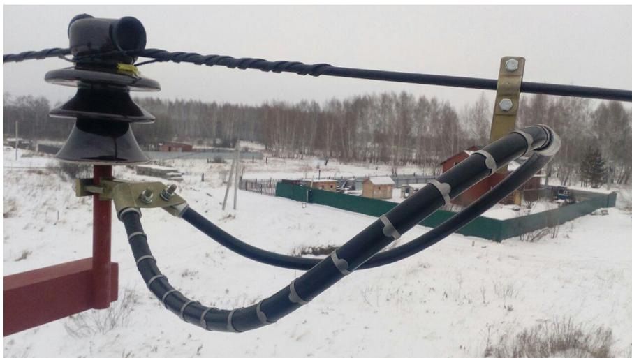
Рисунок 15 – Длинно-искровой разрядник на ВЛ
