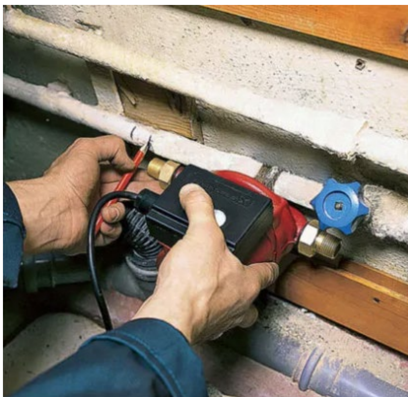
Рисунок 24 – Подключение небольшого повышающего насоса к системе водоснабжения
