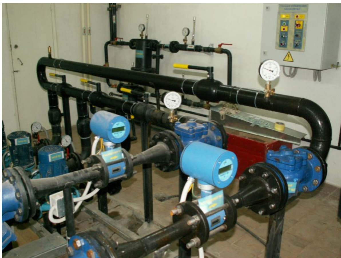
Рисунок 16 – Пример автоматизации повысительной насосной станции жилого дома
