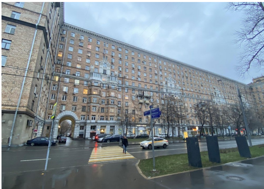
Рисунок 32 – Жилой дом исследуемой ПНС
