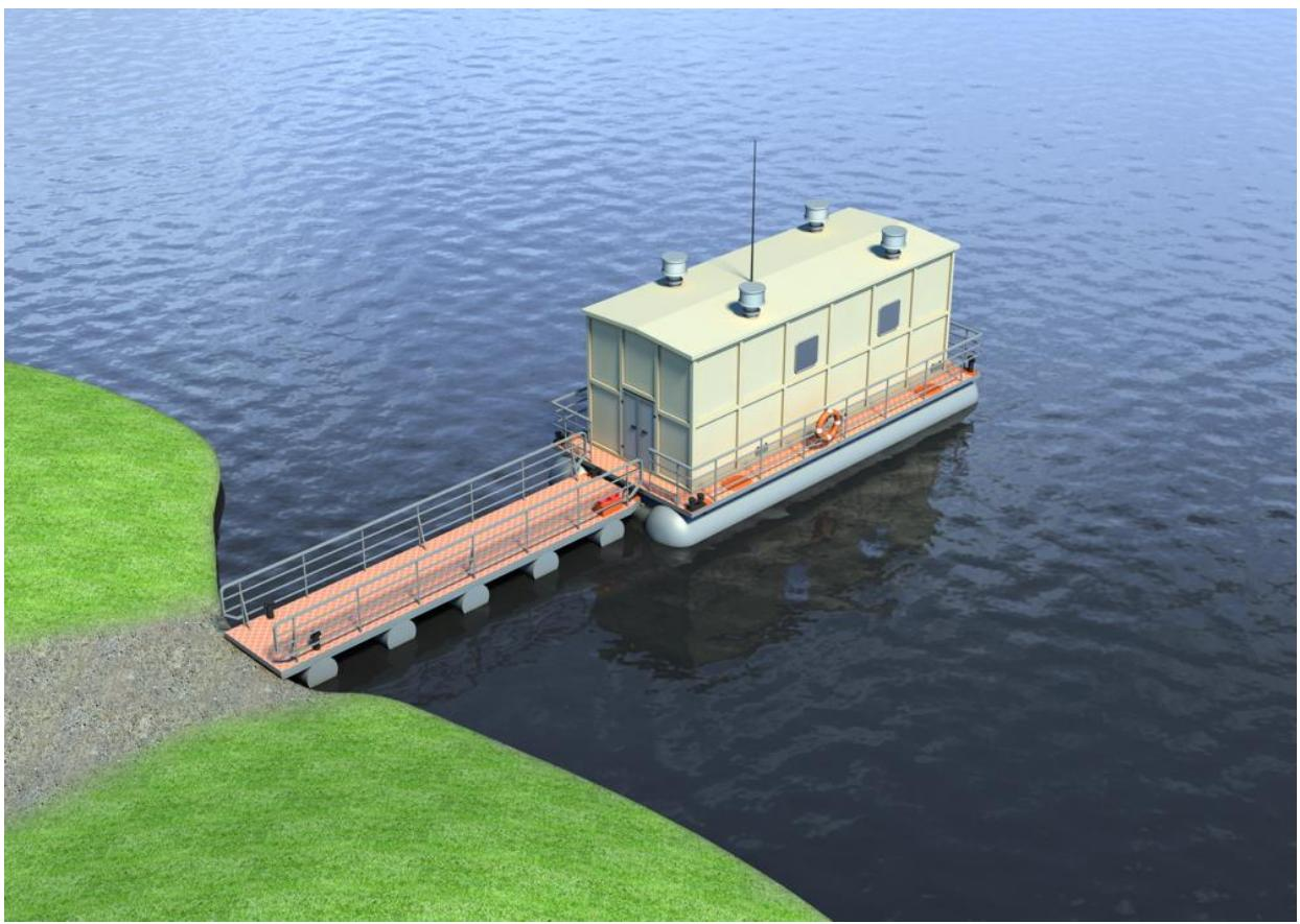
Рисунок 3 – Плавучая станция водозабора
