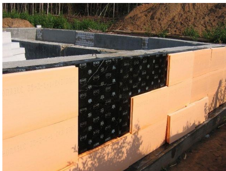
Рисунок 11 – Конструкция цоколя выше уровня земли
