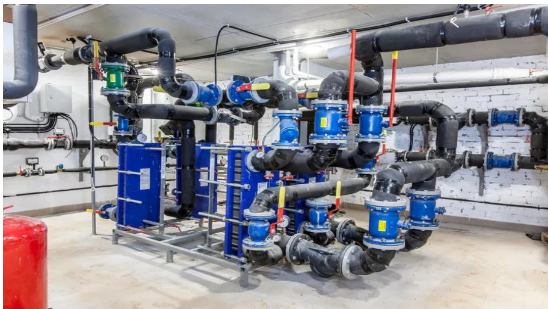
Рисунок 7 – Установка пластинчатого теплообменника в жилом доме
