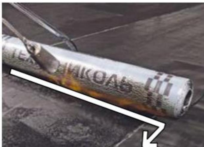
Рисунок 11 – Движение горелки при наплавлении смежных рулонов
