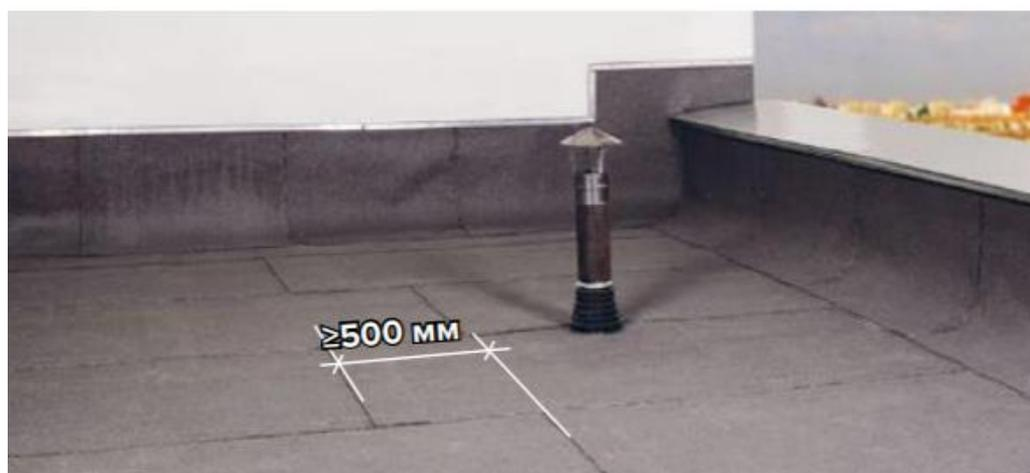
Рисунок 13 – Общий вид кровли после наплавления верхнего слоя
