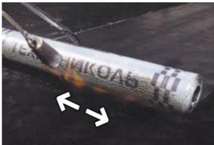
Рисунок 10 – Разогрев рулона
