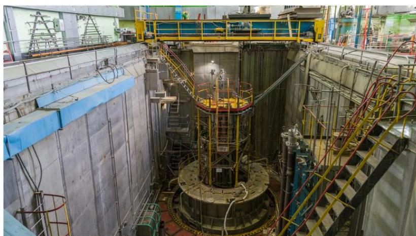
Рисунок 3 – Верхняя часть реактора ВК-50 со снятым защитным колпаком
