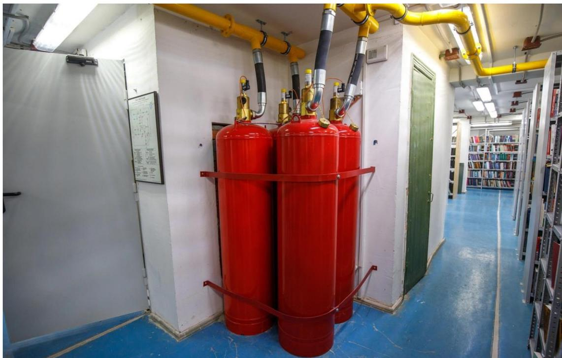
Рисунок 2.6 – САГПТ. Модуль в сборе.
