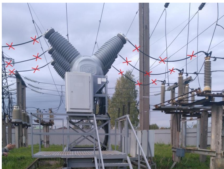
Рисунок 3 – Демонтаж ошиновки выключателя СВ-110кВ (ВТБ-110)
