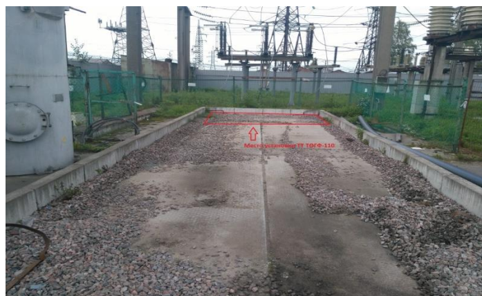
Рисунок 2 – Подготовка площадки под стойки трансформаторов тока
