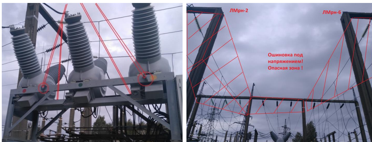
Рисунок 4 – Демонтаж выключателя СВ-110кВ
