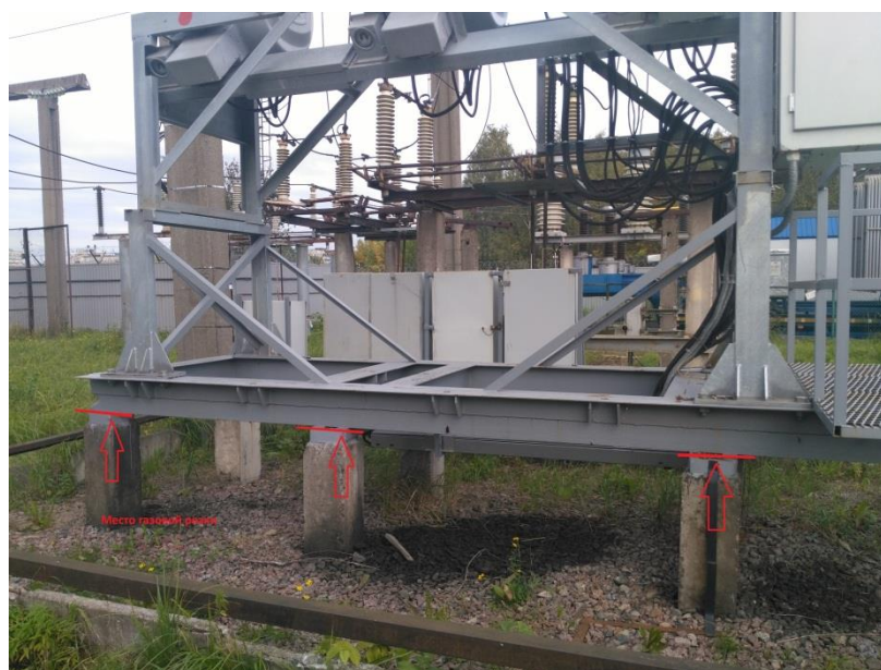
Рисунок 5 – Места среза несущей рамы
