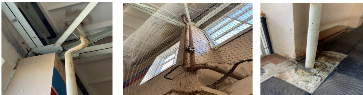
Рисунок 6 – Чугунные водосточные трубы
