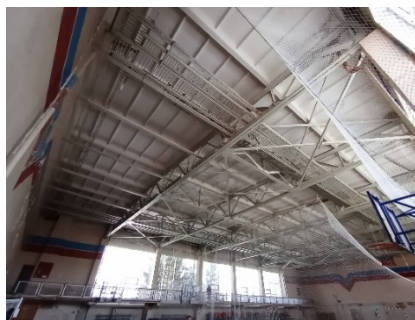
Рисунок 3 – Стальные фермы и горизонтальные связи в спортзале
