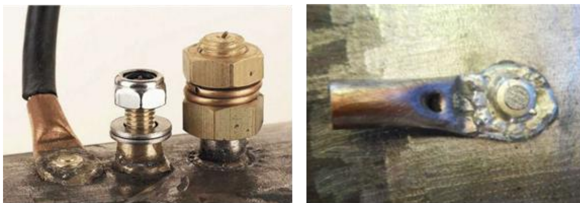
Рисунок 30 - Соединения выводов электрохимической защиты, выполненные штифтовой пайкой.
