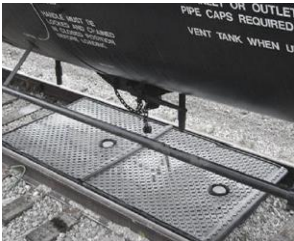
Рисунок 2 – Поддоны для сбора локальных утечек ЛВЖ, ГЖ под ж/д цистернами (США)
