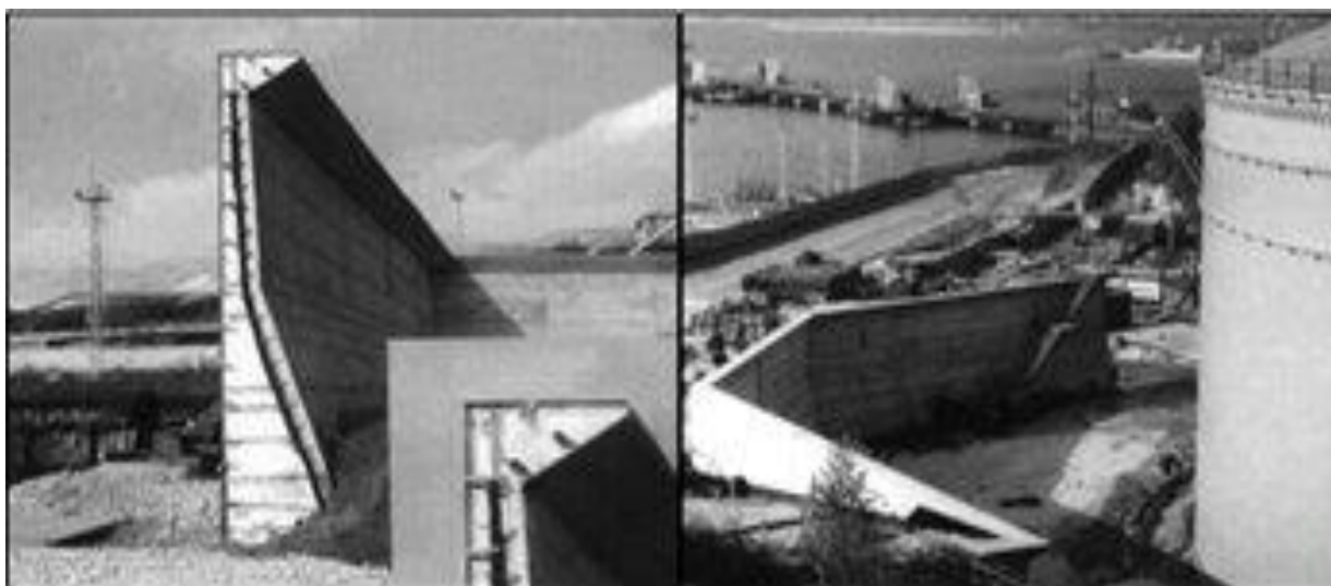
Рисунок 4 – Принципиальная схема ограждающей стены с волноотражающим козырьком
