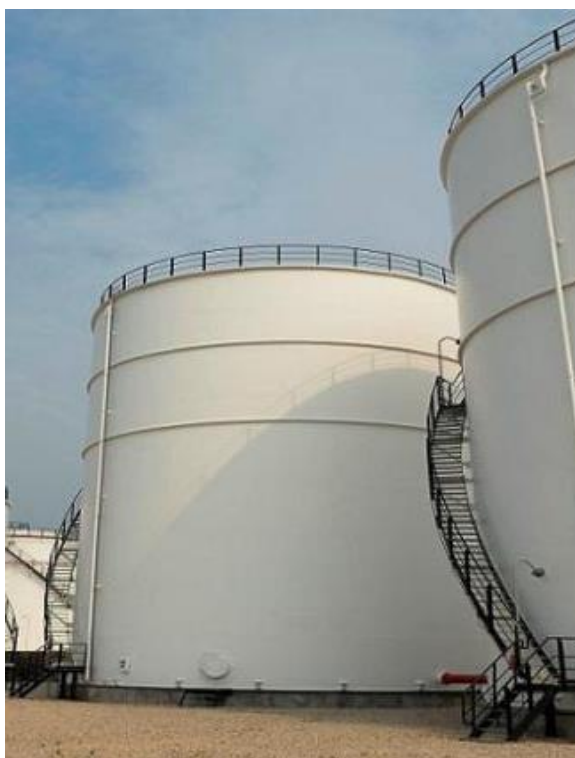
Рисунок 16 – Резервуар типа РВС-2000
