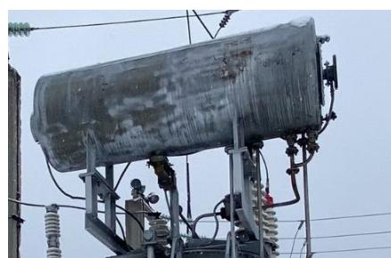
Рисунок 6 – Расширительный бак
