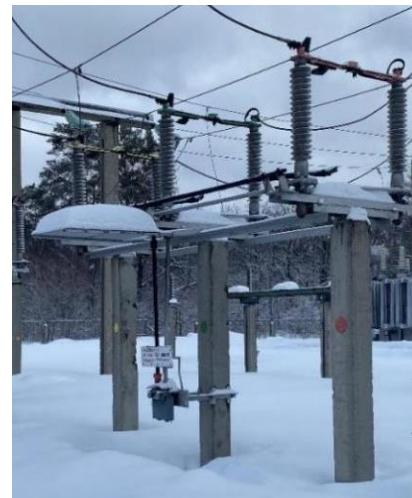
Рисунок 9 – Разъединитель РНДЗ-2-110/630
