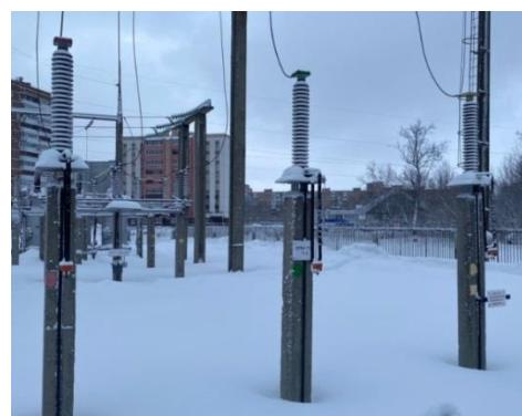
Рисунок 11 – Ограничитель перенапряжений ОПН-П ЗЭУ
