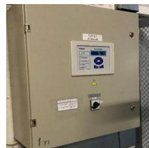
Рисунок 16 – Устройство защиты от дуги
