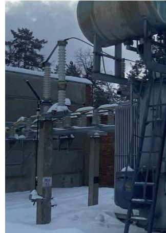
Рисунок 10 – Заземлитель ЗОН-110-М
