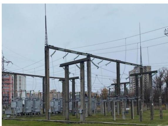
Рисунок 7 – Открытое распределительное устройство
