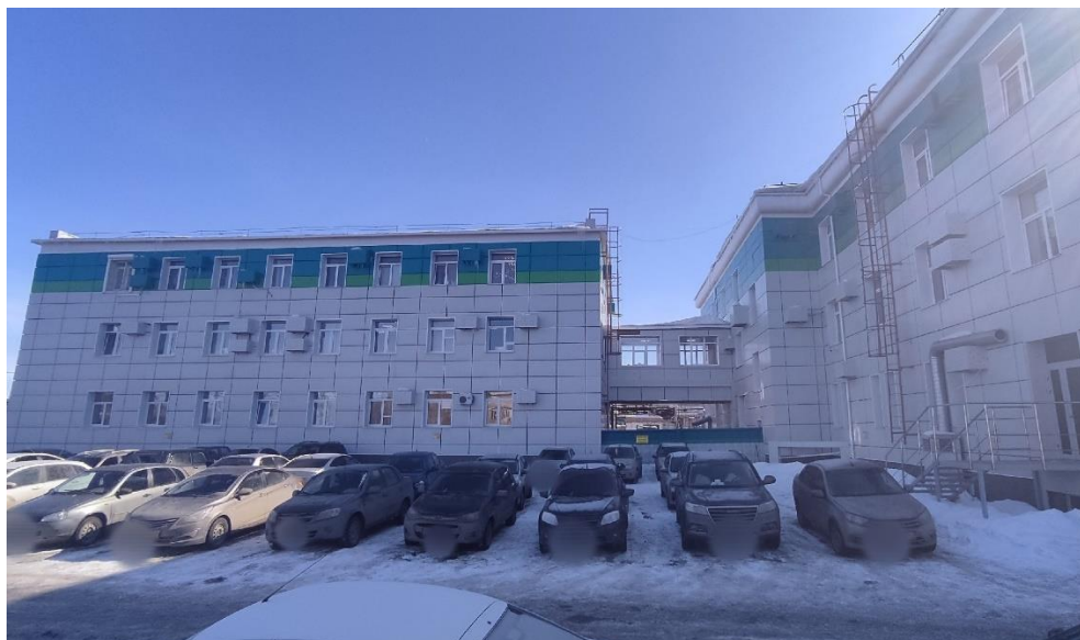
Рисунок 4 – Западная сторона здания заводоуправления №1. Переход и пристроек
