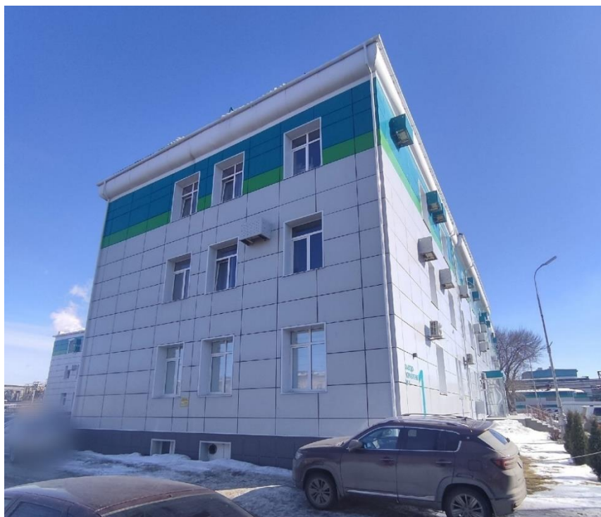
Рисунок 3 – Западная сторона здания заводоуправления №1
