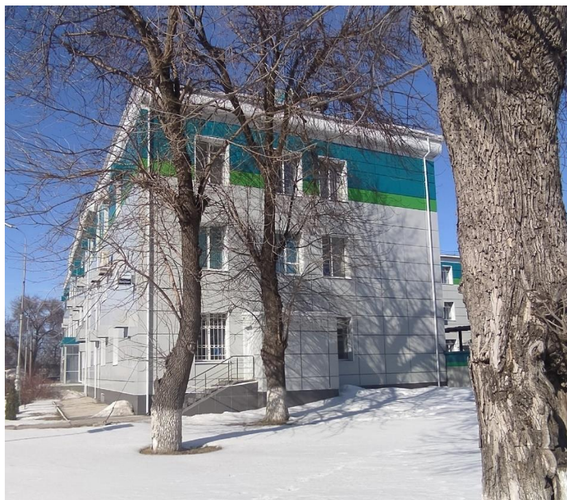
Рисунок 2 – Восточная сторона здания заводоуправления №1
