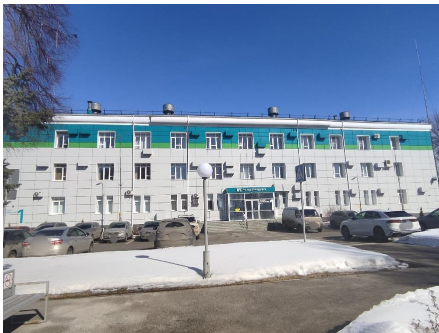
Рисунок 1 – Южная сторона здания заводоуправления №1. Главный вход
