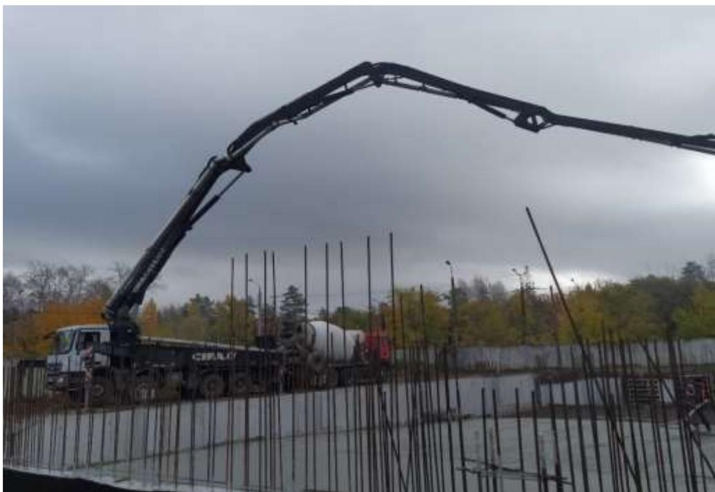
Рисунок 10 – Процесс подачи бетонной смеси через бетононасос
