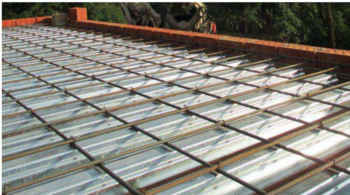
Рисунок 11 – Процесс монтажа опалубки из профлиста и армирования плиты перекрытия
