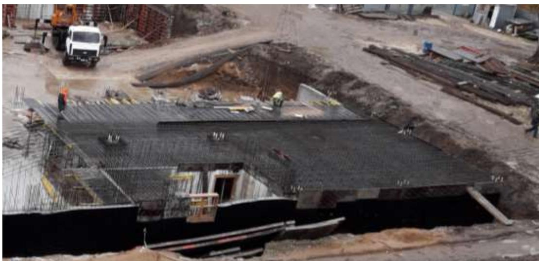
Рисунок 9 – Процесс армирования плиты перекрытия
