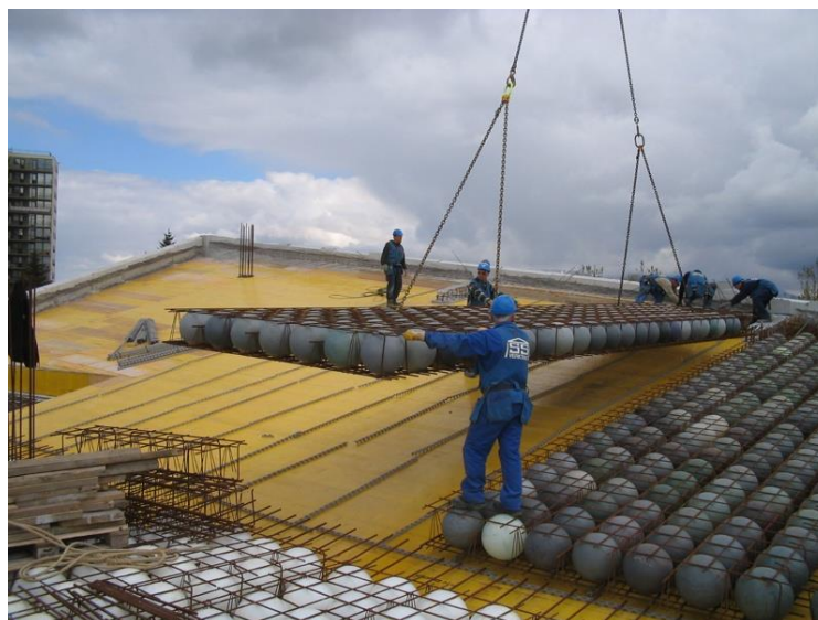
Рисунок 11 – Установка арматурных модулей
