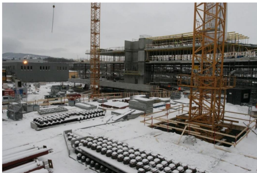
Рисунок 4 – Строительная площадка при строительстве Sogn Arena
