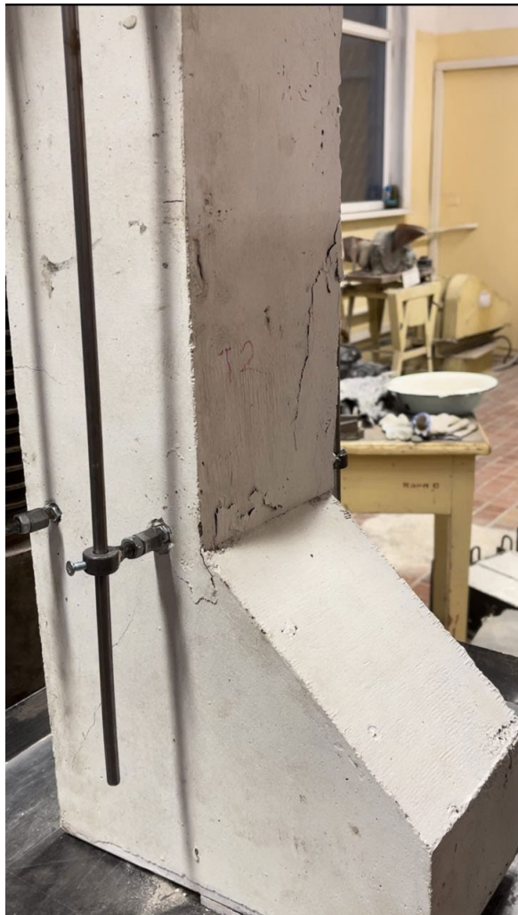
Рисунок 33 – Начало разрушения сжатой зоны колонны КС75
