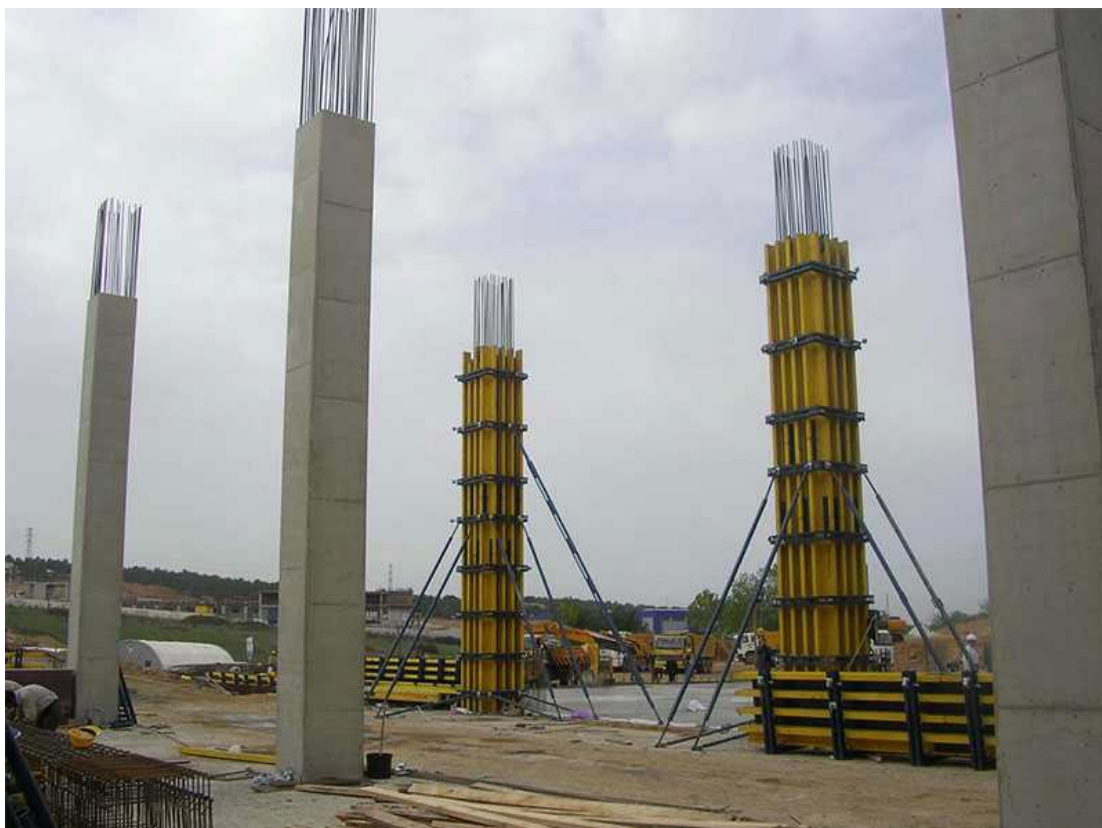
Рисунок 3 – Монолитные железобетонные колонны
