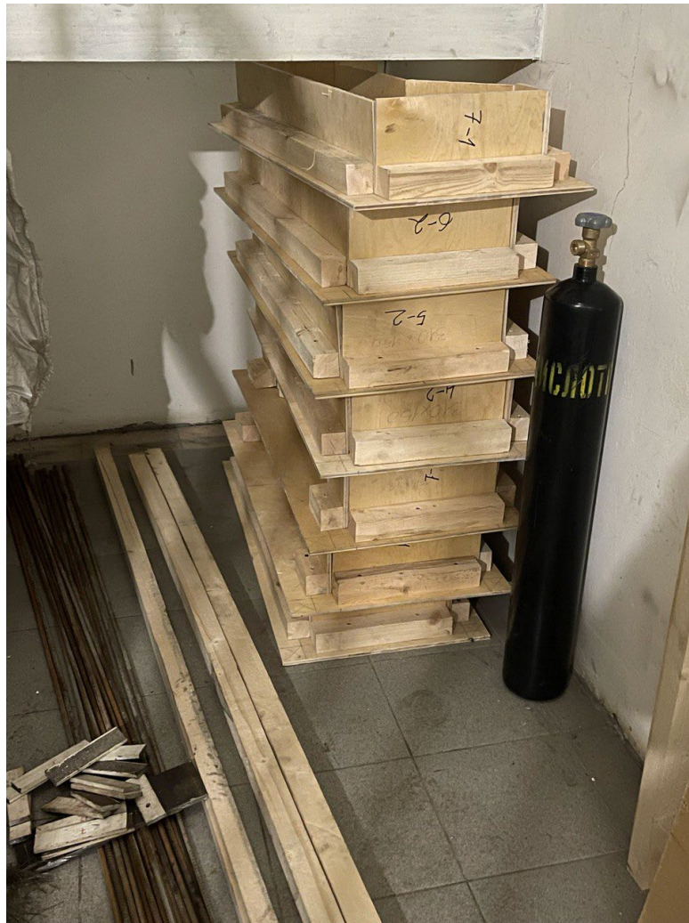
Рисунок 16 – Готовая опалубка
