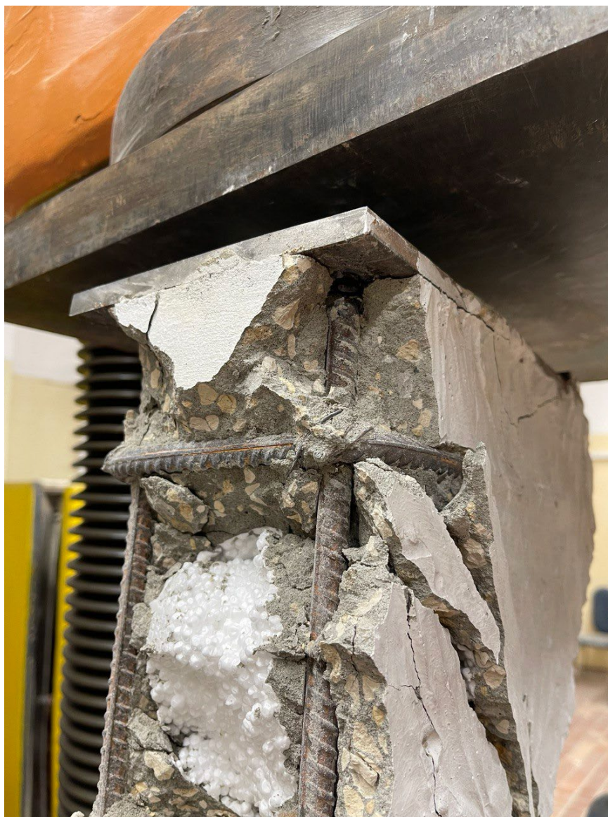
Рисунок 47 – Разрушенная колонна КП212,5
