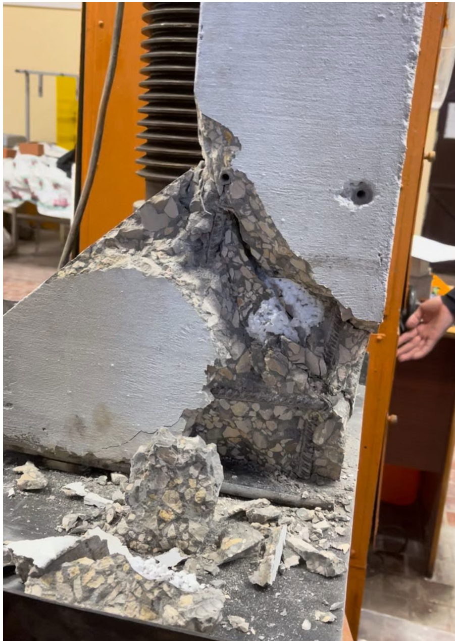
Рисунок 41 – Разрушенная колонна КР112,5
