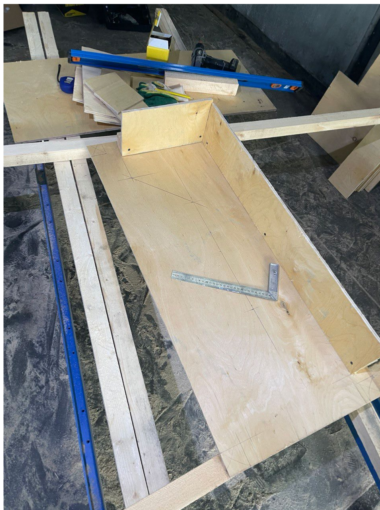
Рисунок 15 – Сборка опалубки
