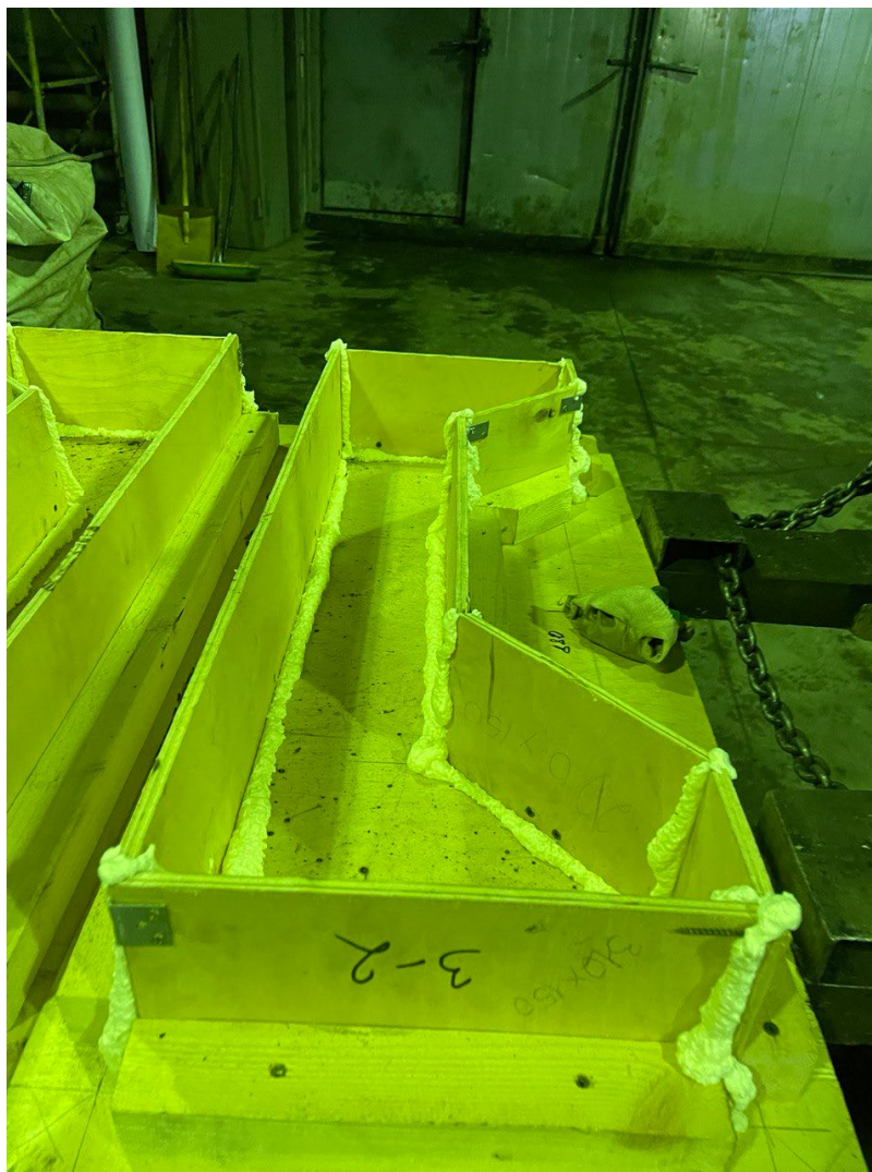
Рисунок 17 – Усиление и изоляция швов опалубки
