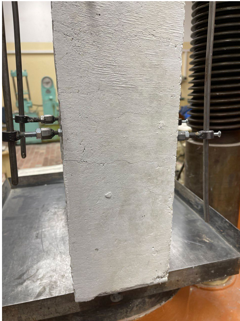
Рисунок 48 – Момент трещинообразования в колонне КС212,5
