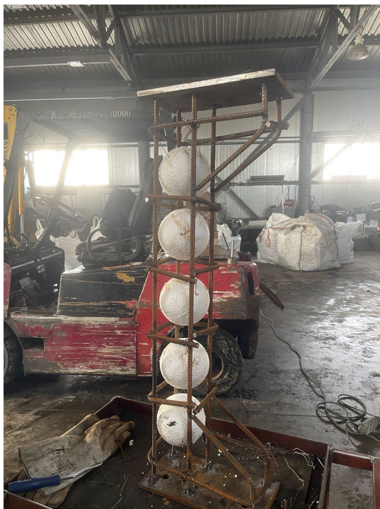
Рисунок 21 – Арматурный каркас с пустотообразователями
