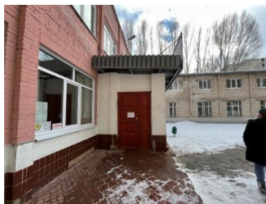
Рисунок 8 – Входная группа в корпуса «Б» и «Д», двери деревянные
