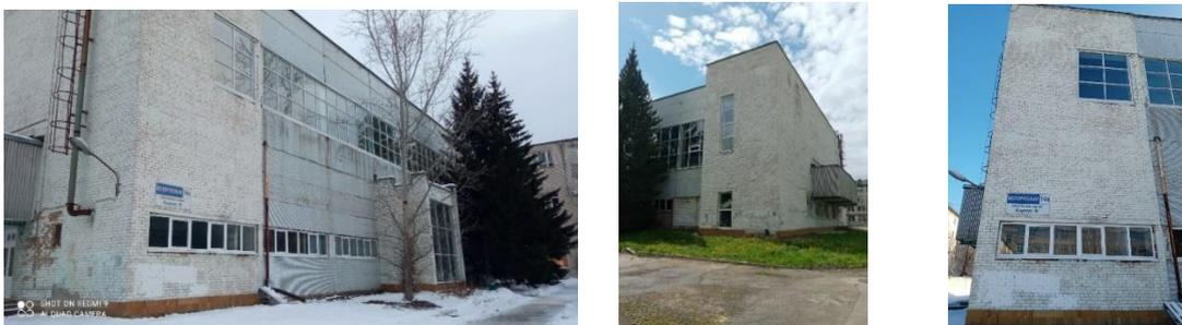
Рисунок 1 – Внешний вид спортивного корпуса ТГУ. Наружные стены из кирпича и железобетонных панелей
