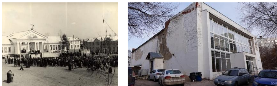
Рисунок 12 — Фасад здания 40 лет ВЛКСМ
