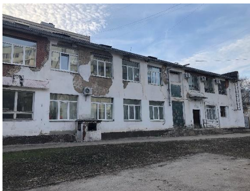
Рисунок 16 — Фасад здания 40 лет ВЛКСМ
