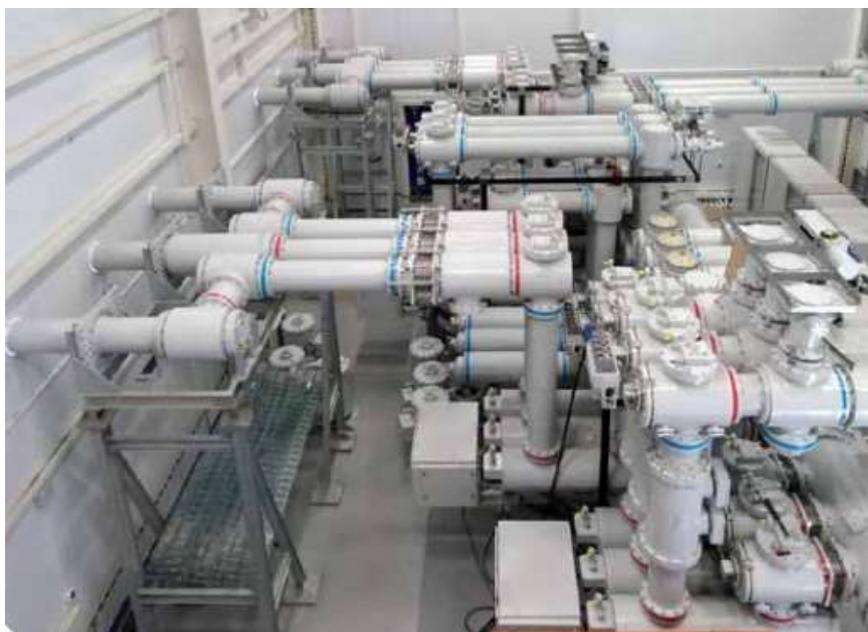
Рисунок 10 – КРУЭ серии ЯГТ-110 производства компании АО ВО «ЭЛЕКТРОАППАРАТ»
