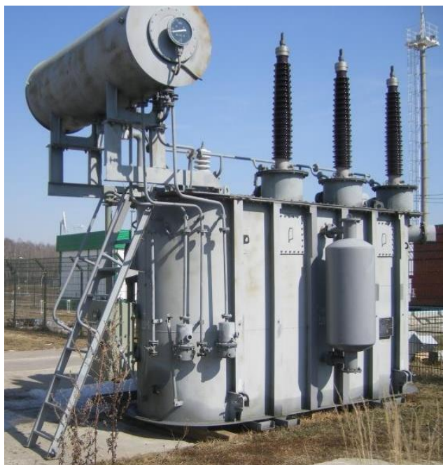
Рисунок 3 – Трансформатор ТДН-10000/110
