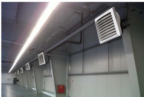
Рис. 2. Пример монтажа воздухонагревателя
