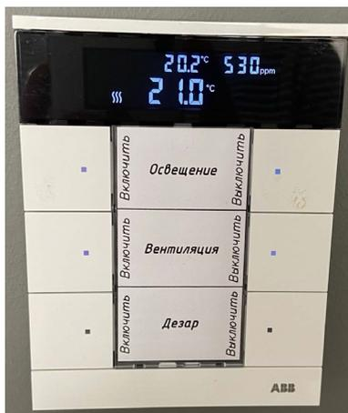
Рис. 3. Сенсор с ЖК дисплеем и встроенными датчиками фирмы АBB
