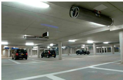
Рис. 1. Пример крытой автостоянки с системой струйных вентиляторов
