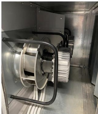
Рис. 1. Приточно-вытяжная установка с применением ЕС-вентилятора
