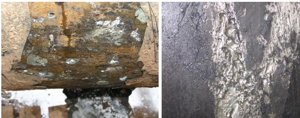
Рисунок 1.1 – Коррозия внешней поверхности трубопровода
