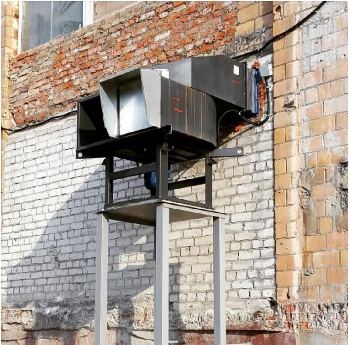
Рисунок 24 – Пристенный вентилятор дымоудаления
