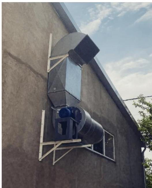
Рисунок 25 – Радиальный вентилятор дымоудаления на фасаде
