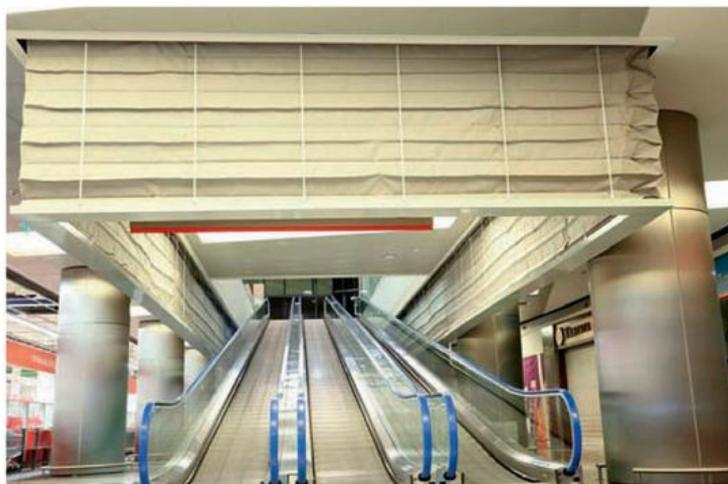
Рисунок 22 – Противопожарная штора-гармошка в ТЦ «Порт»
