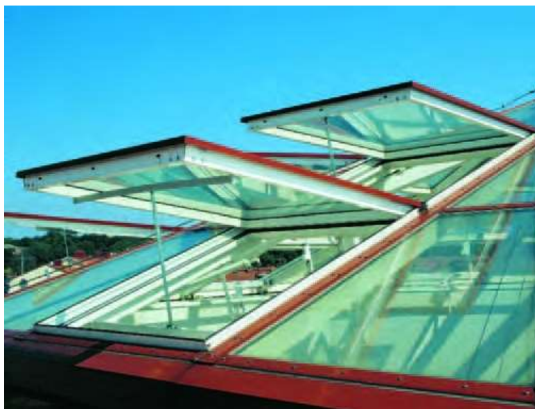
Рисунок 1 – Вентиляционные отверстия в крыше
