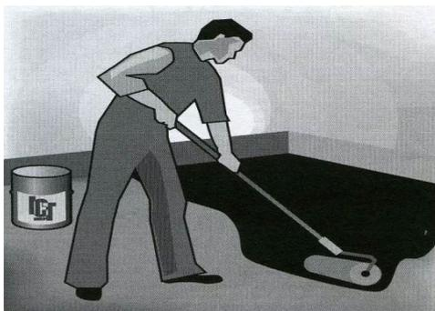
Рисунок 5 – Нанесение огрунтовки битумным праймером
