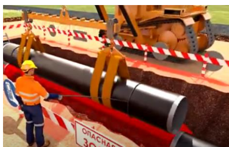
Рисунок 27 - Строповочное оборудование для черновой “катушки” 5м
