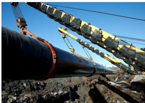
Рисунок 2 - Строительство газопровода «Ухта-Торжок»
