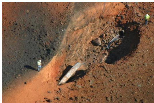
Рисунок 4 - Вид сверху на последствия аварии
