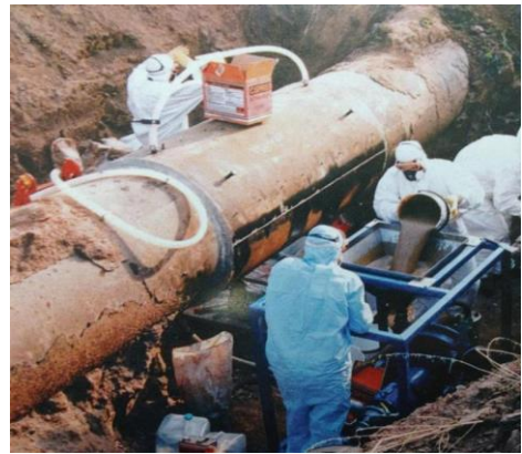
Рисунок 11 – Устройство ремонтной муфты и её установка на магистральный трубопровод
