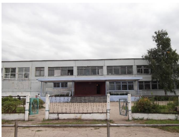
Рисунок 1 – Вид здания по улице Новостроящаяся
