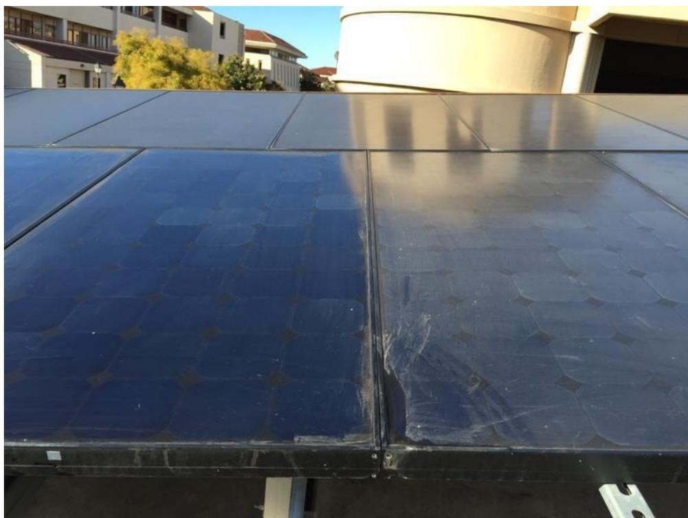
Рисунок 18 – Очищенная панель (слева) и загрязненная панель (справа)
