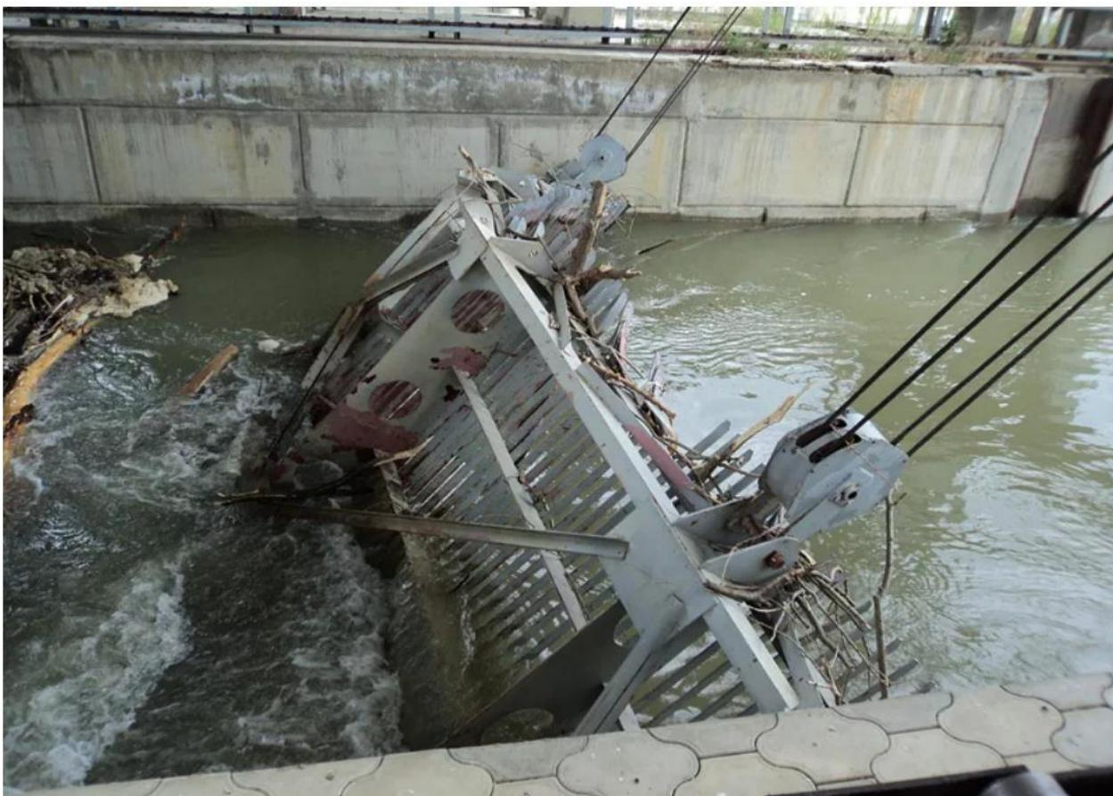
Рисунок 26 – Защитная сетка на ГЭС
