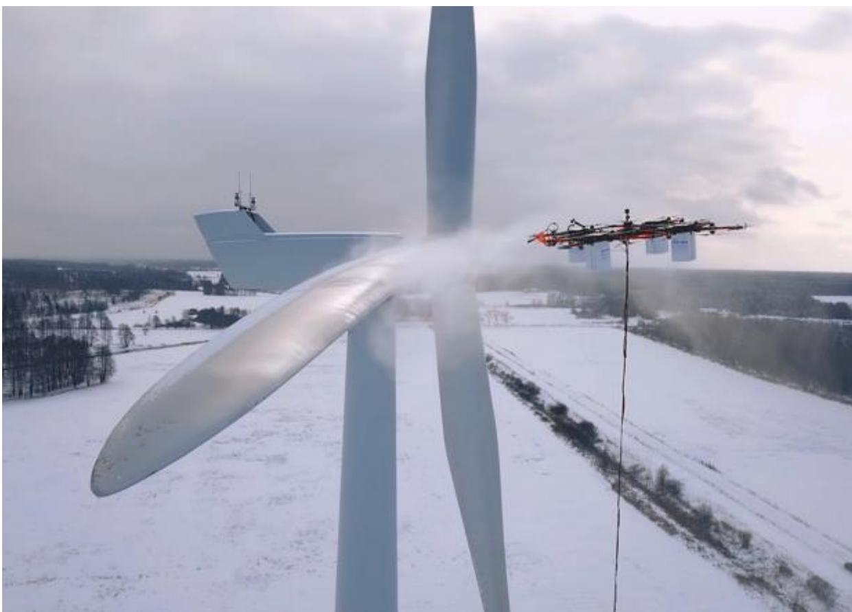
Рисунок 25 – Дрон для очистки лопастей
