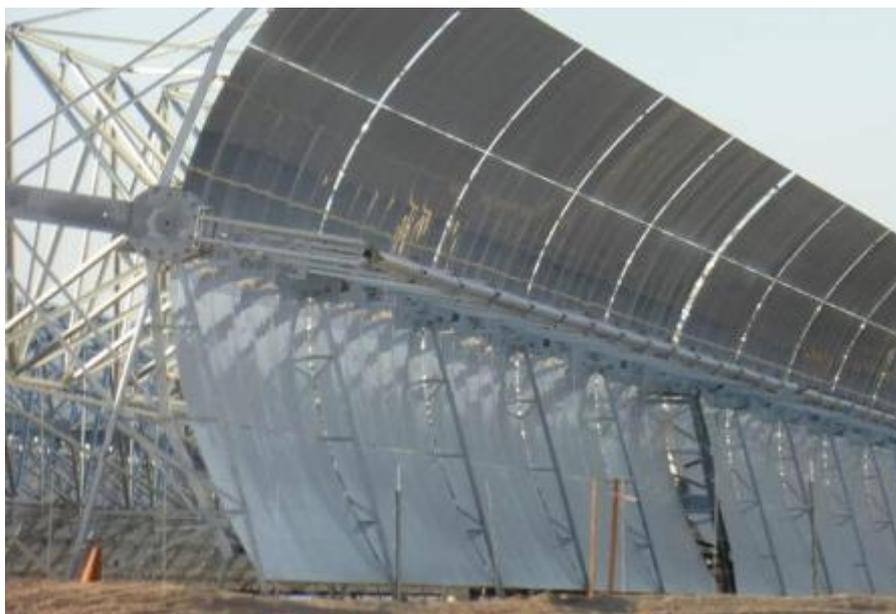
Рисунок 13 – Параболоцилиндрические концентраторные СЭС
