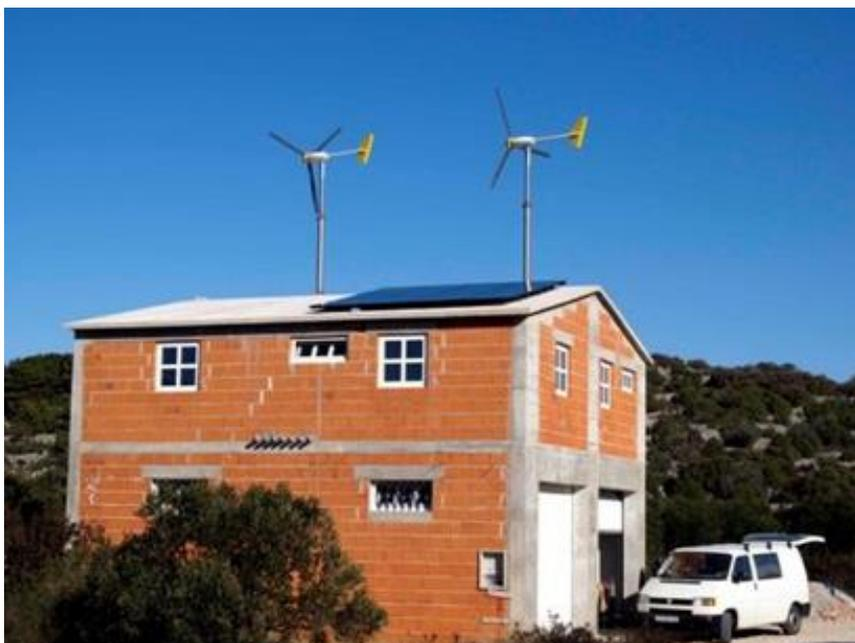
Рисунок 10 – Система Bergey 1кВт
