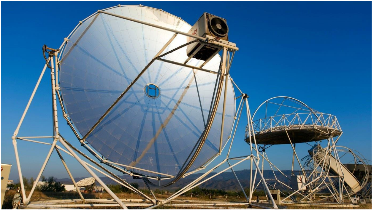
Рисунок 2 – Солнечная электростанция тарельчатого типа
