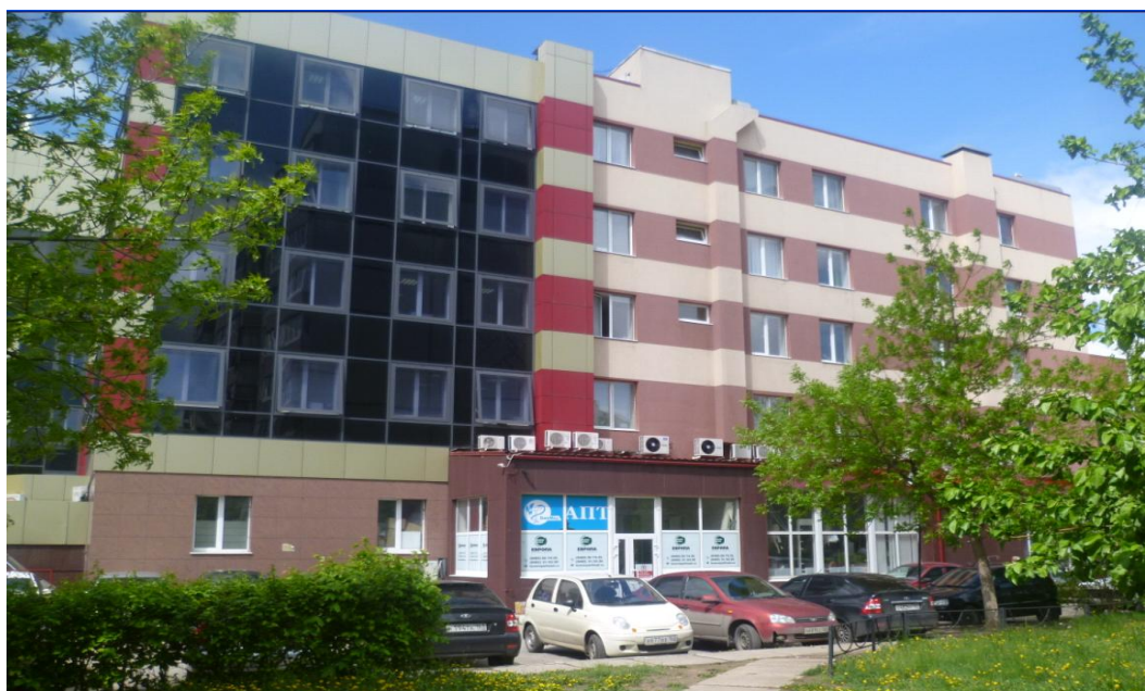
Рисунок 1.4 - Вид объекта (восточная сторона)
