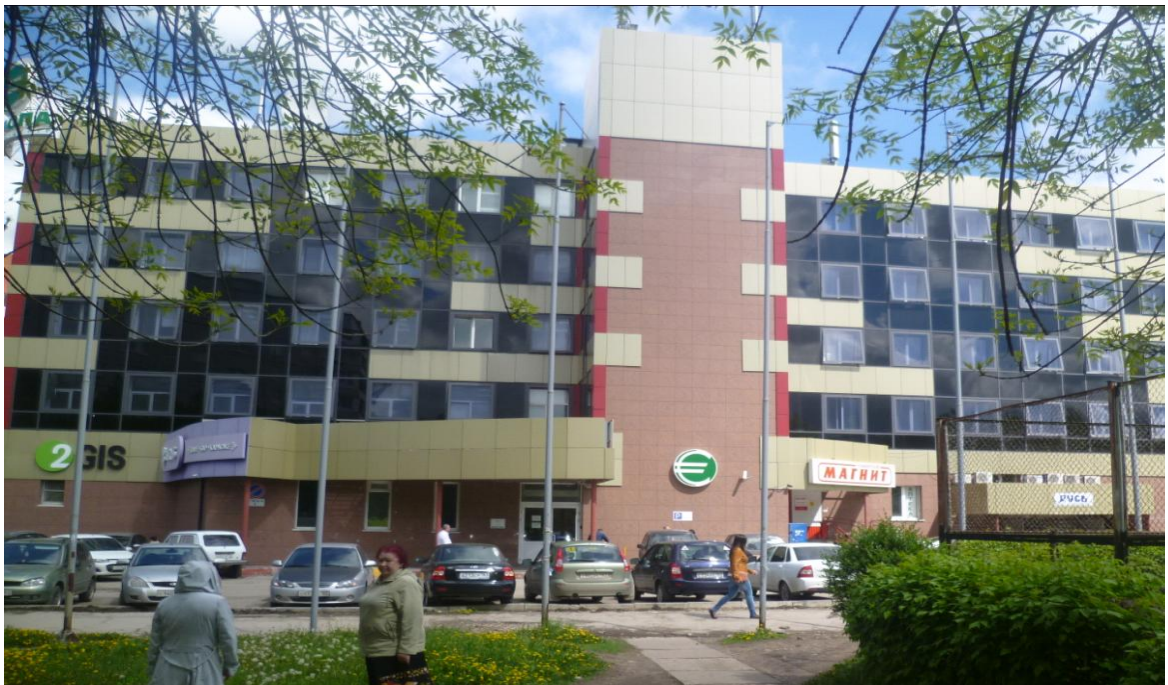
Рисунок 1.2 – Вид объекта (южная сторона)
