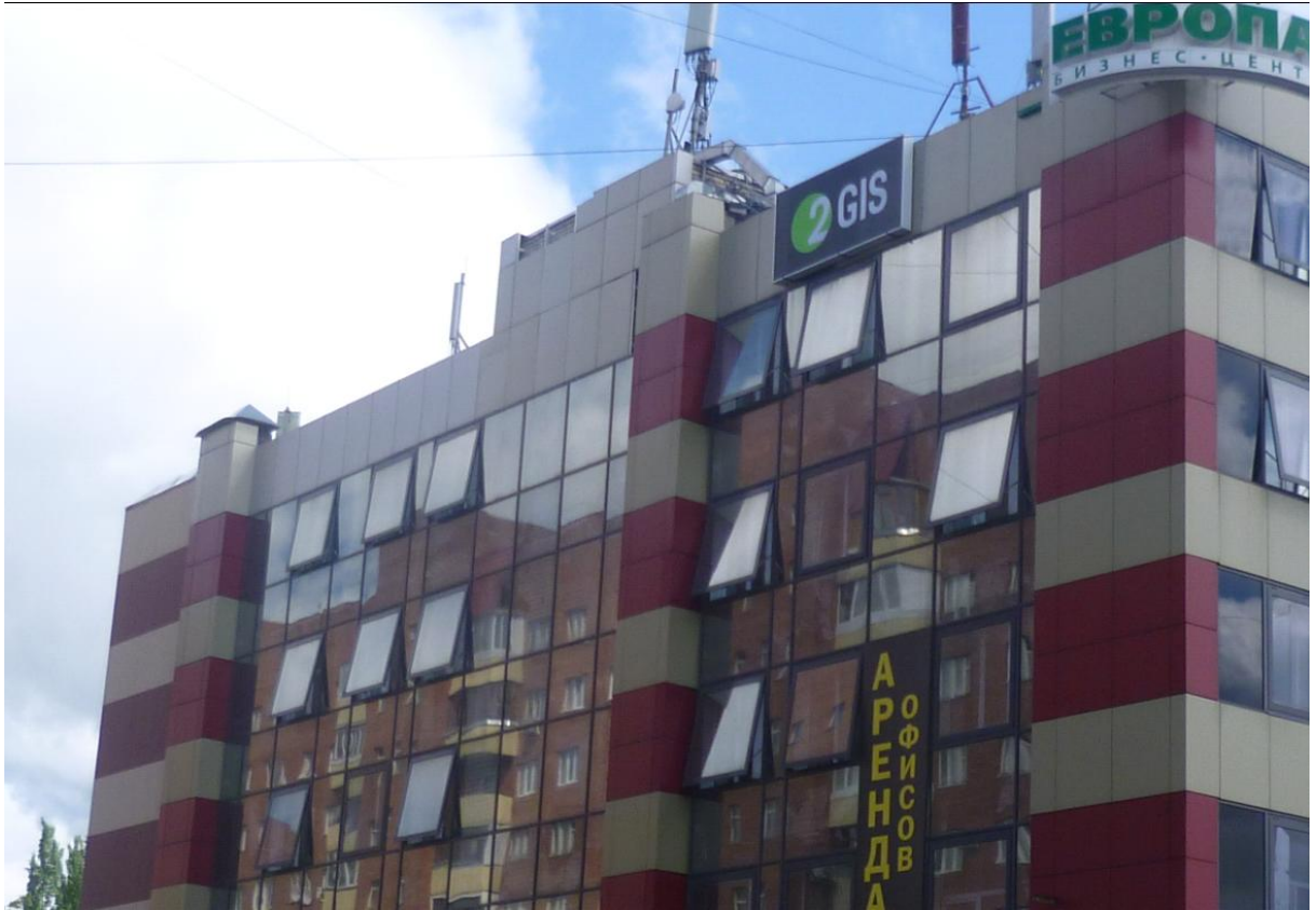
Рисунок 1.1 - Вид здания (западная сторона)
