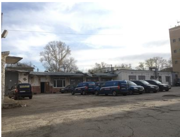
Рисунок 1 – Общий вид транспортного участка Тольяттинского почтамта
